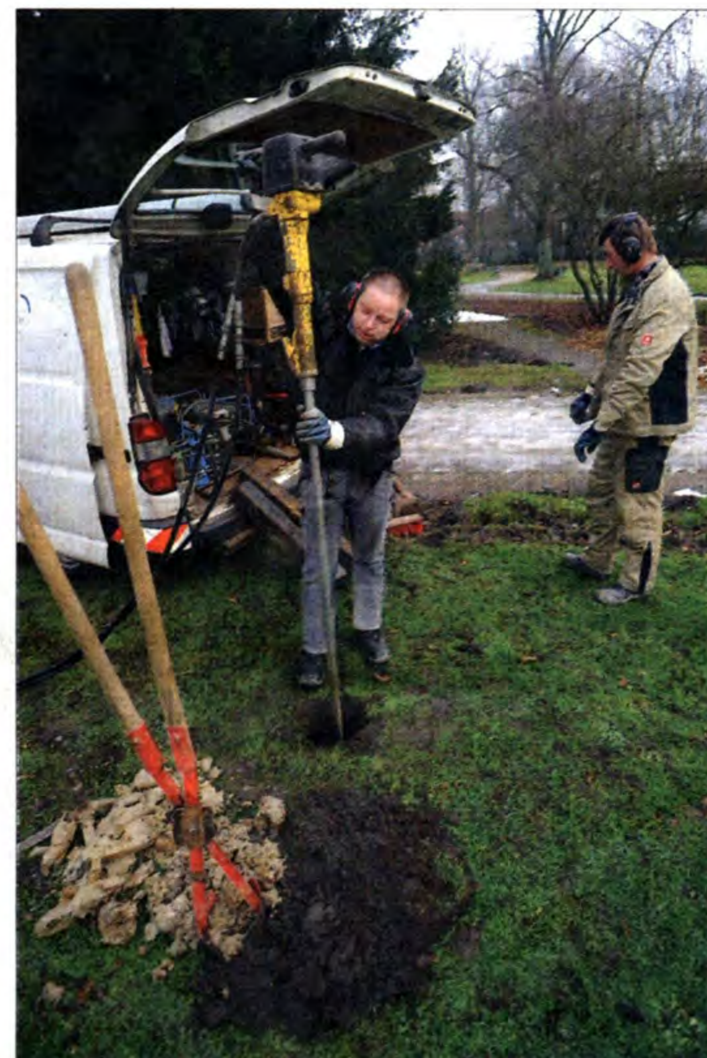
Andreas Hollmann rammt die Sonde in den Boden, Gerhard Eichberg dokumentiert Erdschichten. Schon 1907 wurde hier gebohrt. F.: t & w
