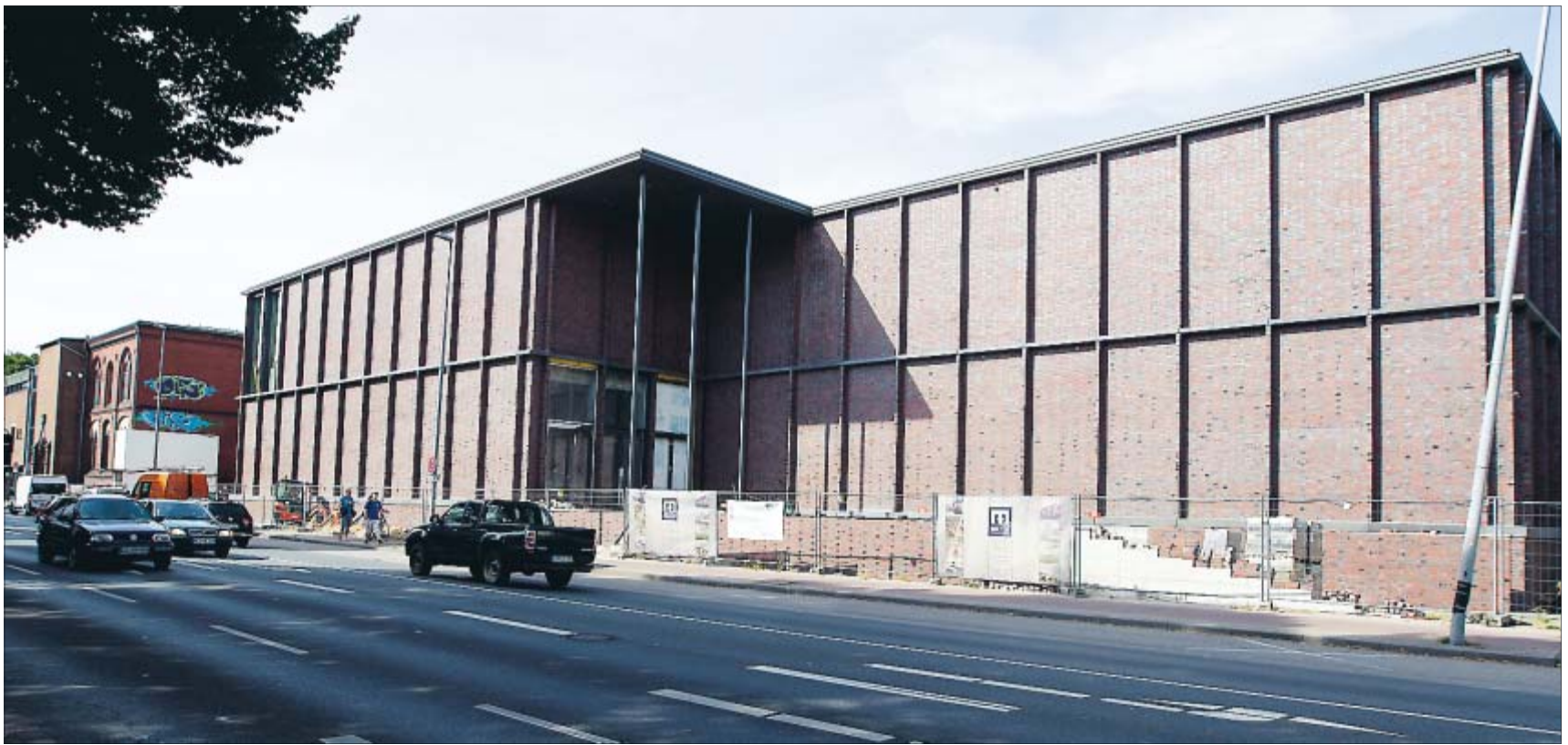
Noch ist der Eingangsbereich nicht gestaltet, aber der Charakter des in sich gegliederten, massiven Baus zur Willy-Brandt-Straße ist gut zu erkennen.
